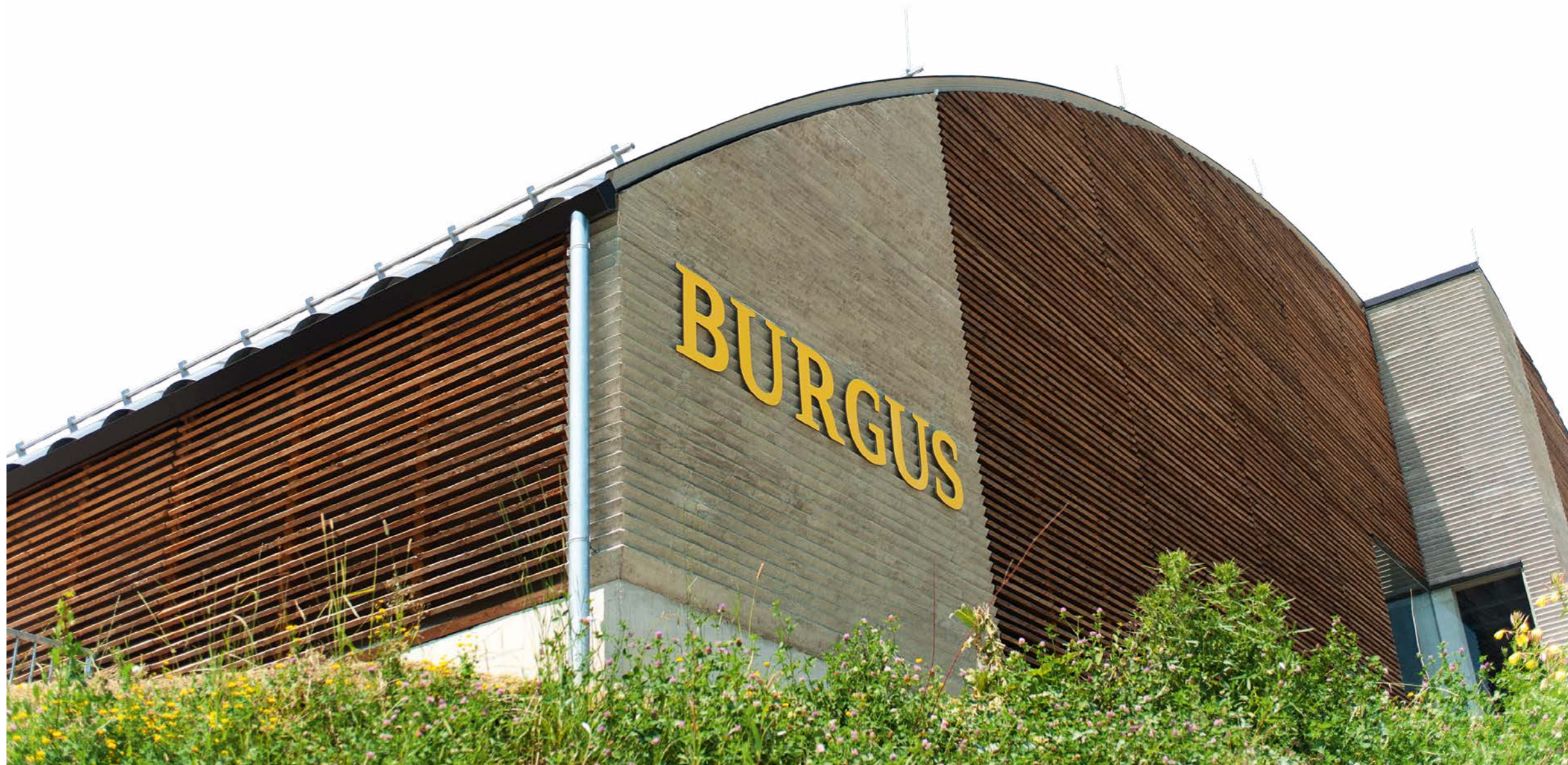
Schutzbau Römerburgus Oberranna – Außenansicht
