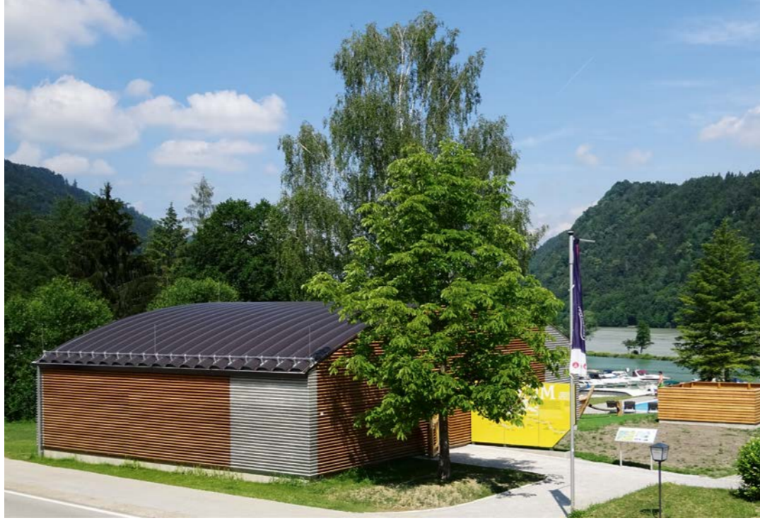
Schutzbau Römerbad Schlögen
